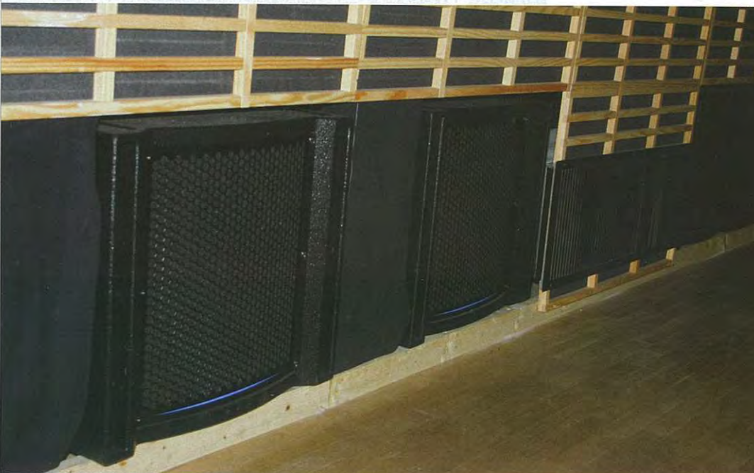
Les caissons de basse TB1155 placés sous la scène sont amovibles
